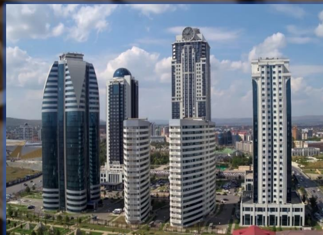
Комплекс высотных зданий «Грозный - Сити»
